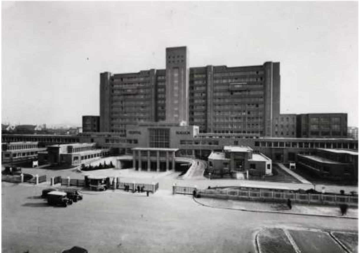
Photo de la façade nord du bâtiment Nicolas Beaujon. Source : Archives AHP.
