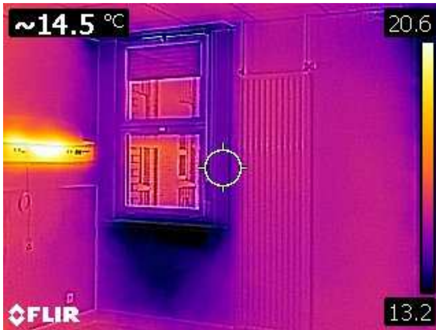
Thermographie intérieure d'une chambre, oct 2019
