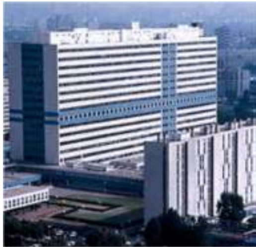
L'Hôpital Henri-Mondor à Créteil. Source : Catherine Fermand.
