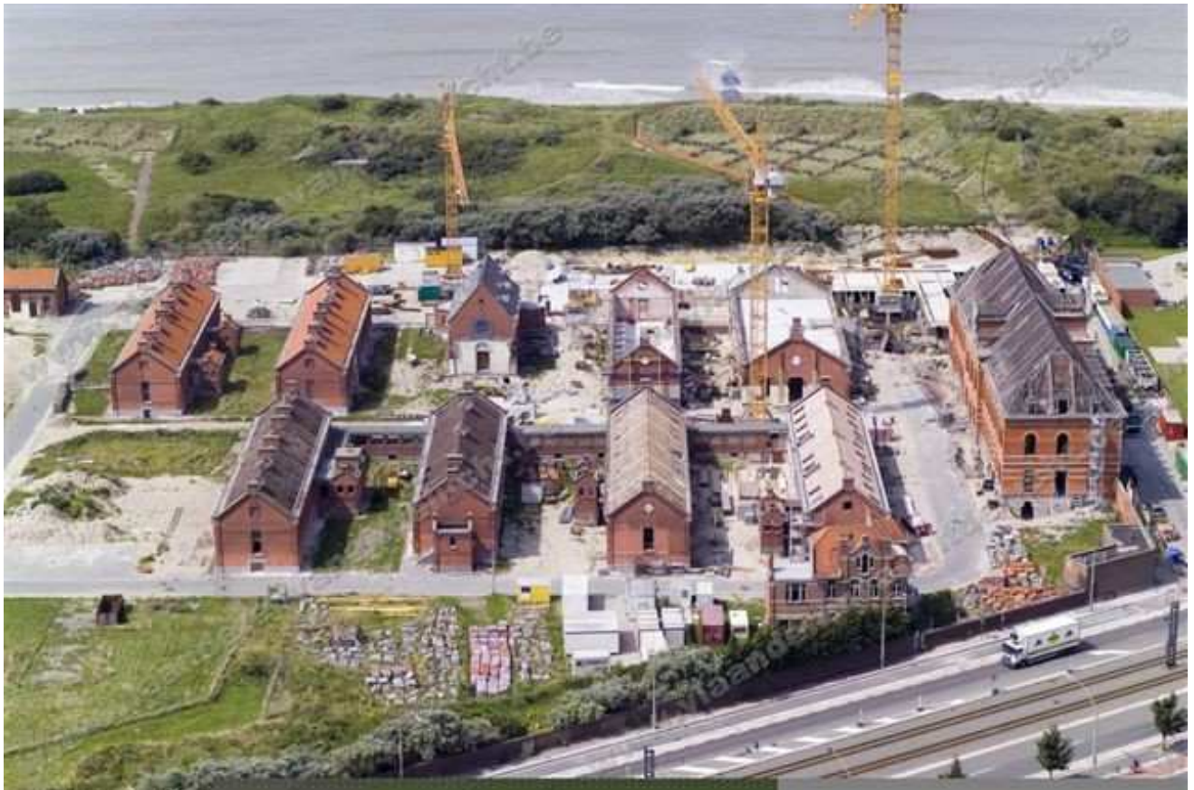
Photo aérienne du site pendant le chantier. Source : © Wienerberger NV/SA
