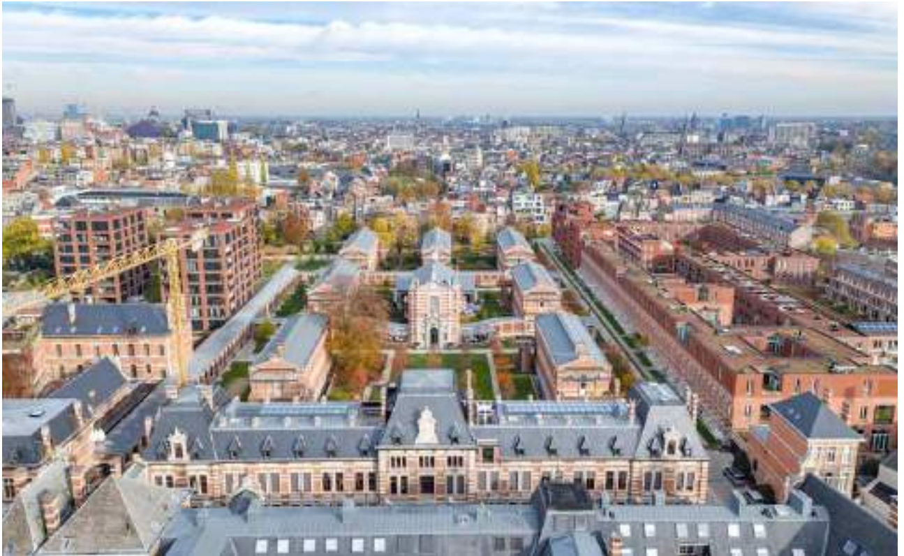
Vue aérienne sur site vers le centre-ville d'Anvers au nord, au premier plan le bâtiment de l'état-major. Source : Achtergael architects
