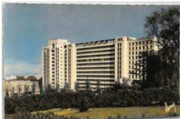
2/ Construite comme un hôpital, la maison médicale de Châtillon sous Bagneux n'a finalement jamais reçu d'activités hospitalières. Après la Seconde Guerre mondiale, la vocation du bâtiment a changé: il accueille depuis les bureaux de l'O.N.E.R.A
