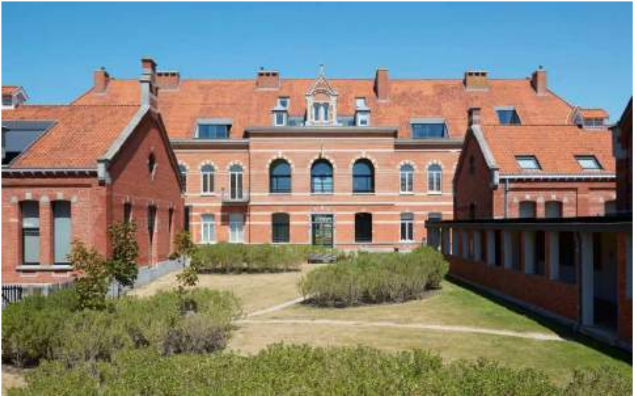
Le bâtiment principal réhabilité. Source : © Wienerberger NV/SA
