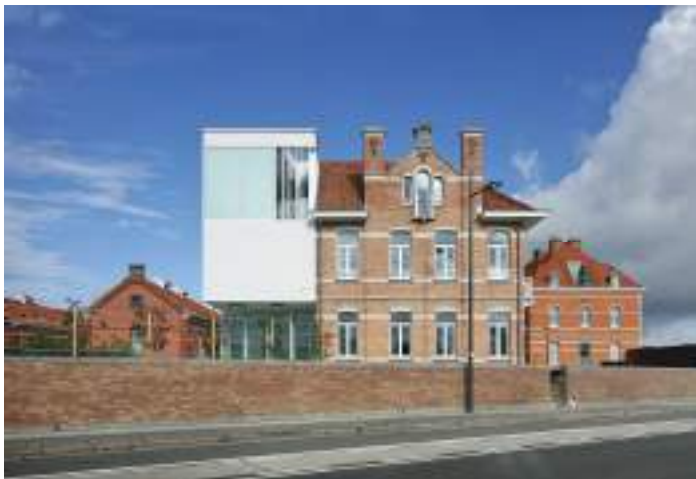
Extension de la maison des officiers. Source : © Wienerberger NV/SA
