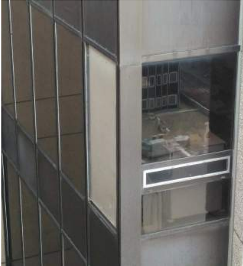
Photo de l'angle d'une aile d'hébergement en octobre 2019. A gauche manque le panneau en verre émaillé tombé à la suite de la canicule de l'été 2019. Photo Marc Benard
