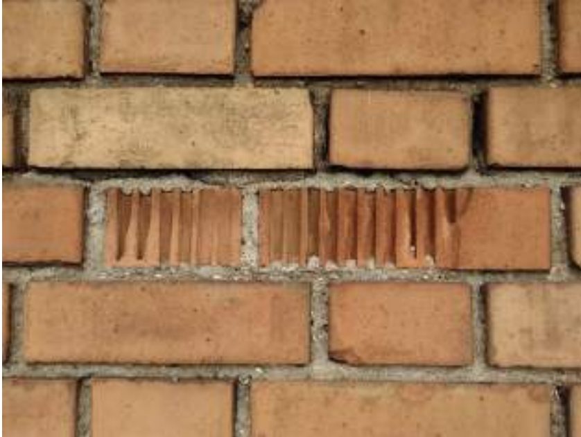
L'éclatement localisé du parement révèle des alvéoles des briques Dazy-Eco
