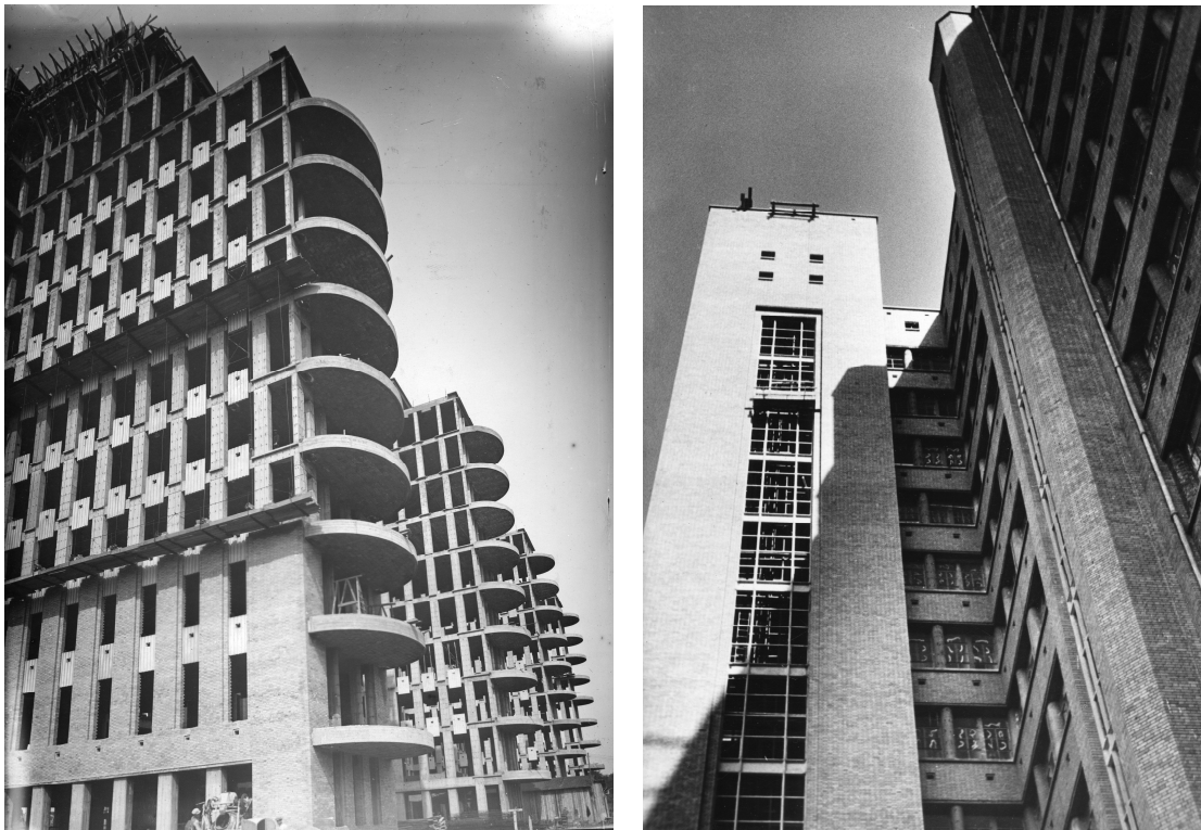
Hôpital Beaujon : pendant le chantier des années 1930. Source : Archives APHP
