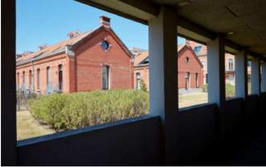
Les pavillons réhabilités. Source : © Wienerberger NV/SA
