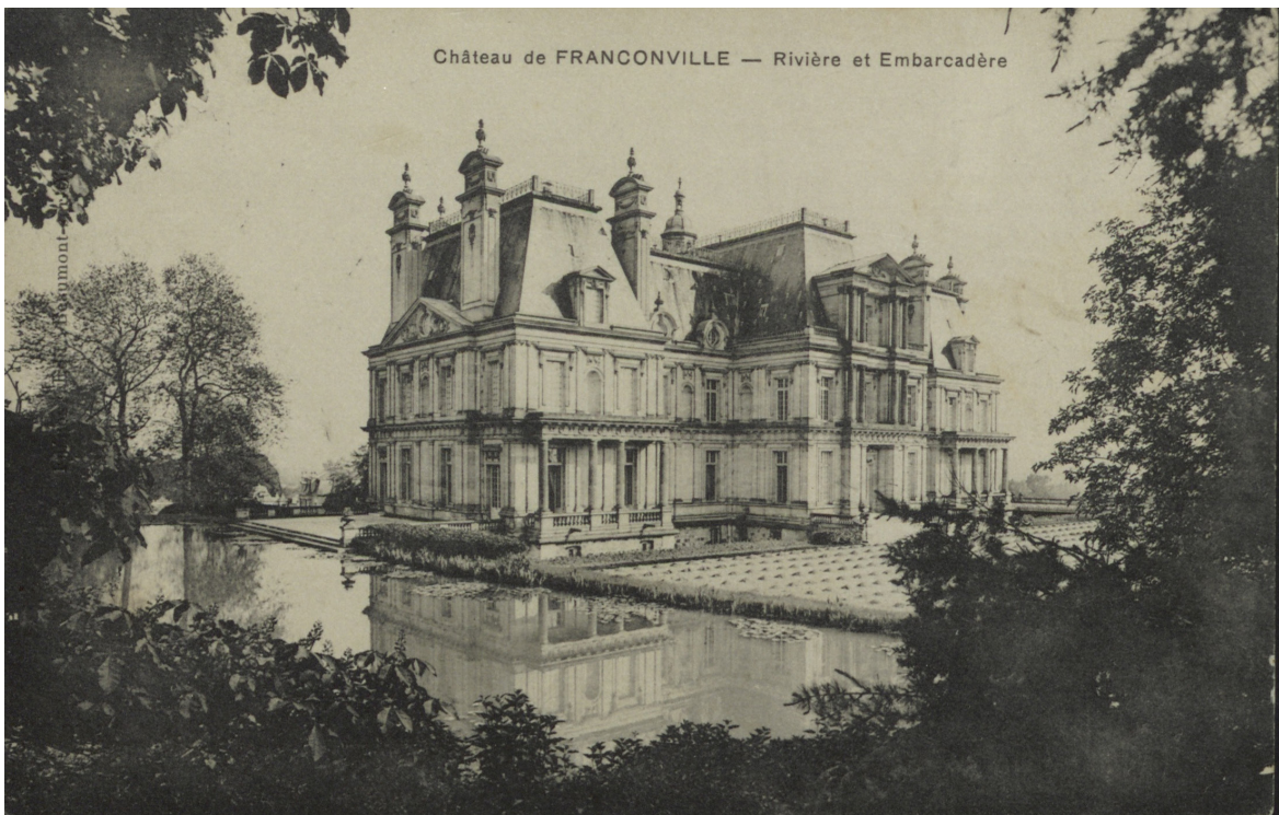
Figure 11 : photographie de la façade arrière du château, AD 95.
