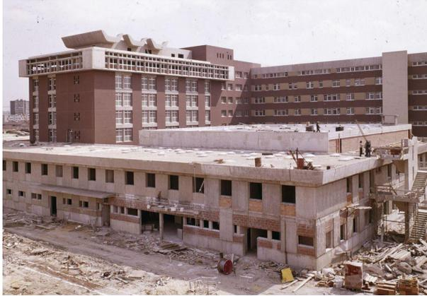
Pendant la construction, dans les années 1970, la structure composite d'éléments en béton armé et de briques est visible.
