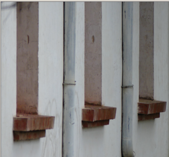
fig.107 - Appuis de fenêtre Photographie personnelle.
