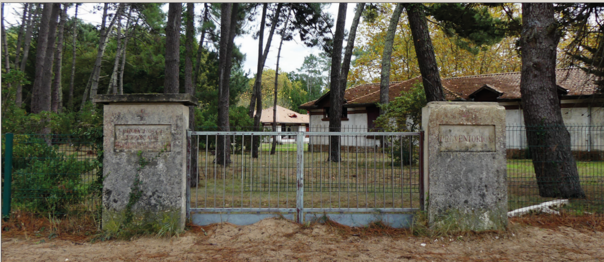
fig.73 - Accès condamné Photographie personnelle.
