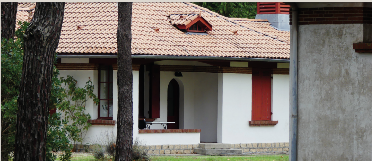
fig.83 - Ancien pavillon d'observation rénové Photographie personnelle.
