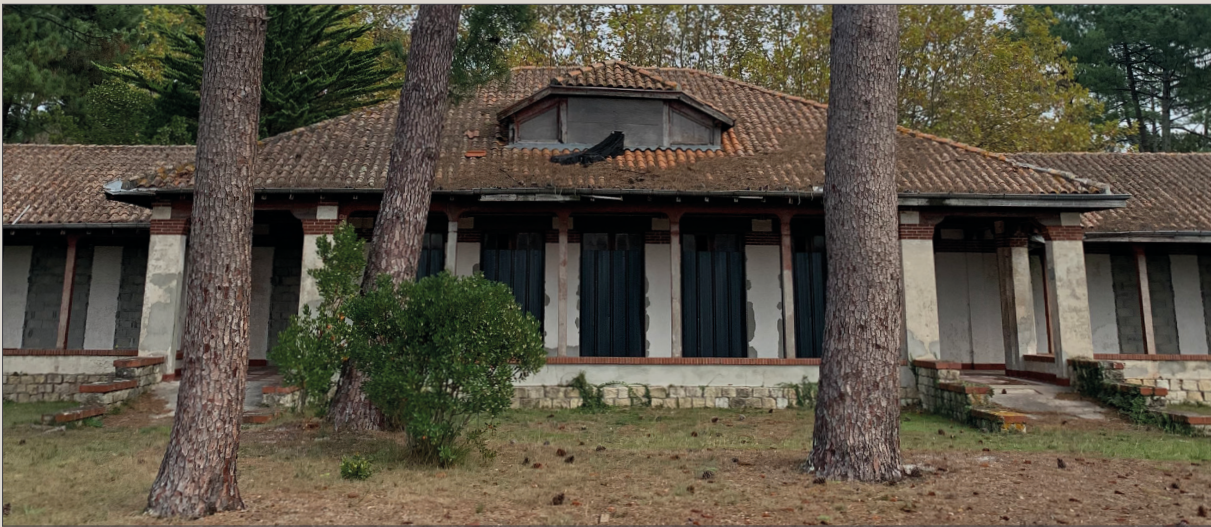
fig.97 - Façade principale de l'Aérium Photographie personnelle.
