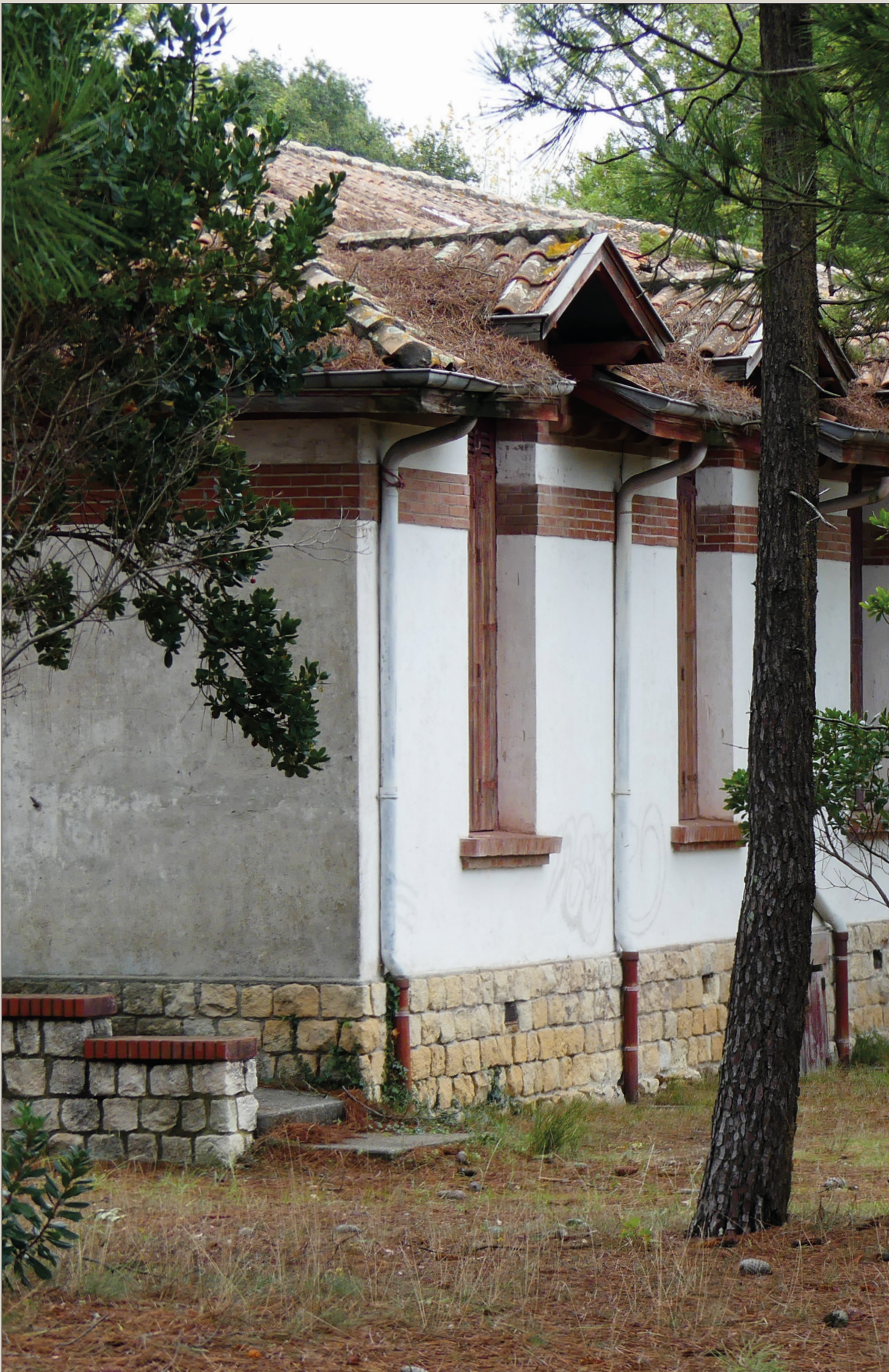
fig.104 - Dernière extension du bâtiment principal de l'Aérium Photographie personnelle.
