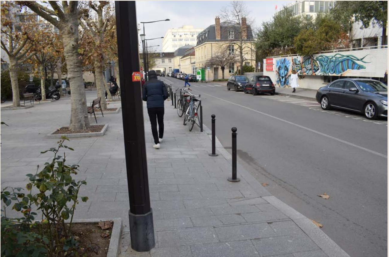
**Figure 18 - Bateau (sur le trottoir qui longe l'amphithéâtre de stomatologie), une personne mal voyante pourrait l'interpréter comme une possibilité de traverser, 2022**
