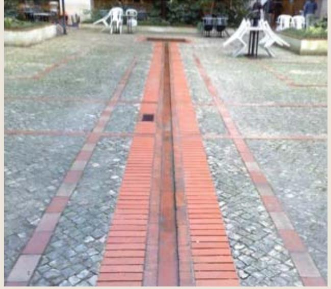
**Figure 63 - Marquage au sol pour l'accès au jardin et à la terrasse pour l'accessibilité aux personnes en déficience visuelle, un cheminement pour l'eau de pluie qui guide l'utilisateur. Vue du dispositif avant/après, 2011**
