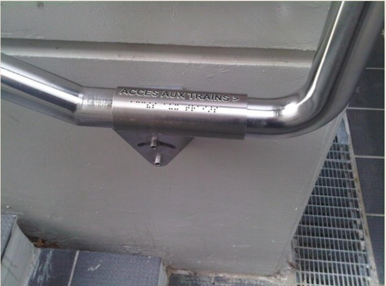
**Figure 67 - Dispositif de manchon tactile à apposer sur des mains courantes , 2006**
