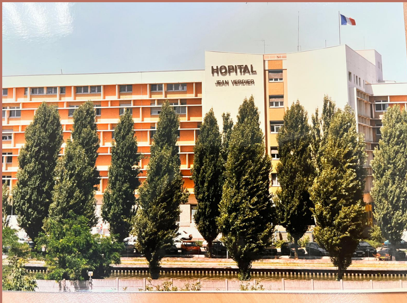
Figure 27: Photo de l'Hôpital Jean Verdier facade Sud, issue des archives de l'APHP
