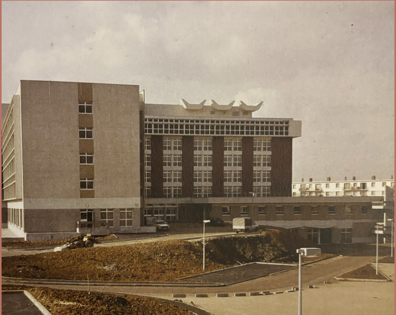
Figure 42: Photo de la facade Est du bâtiment 205, 1973-1975, issu des archives de l'APHP
