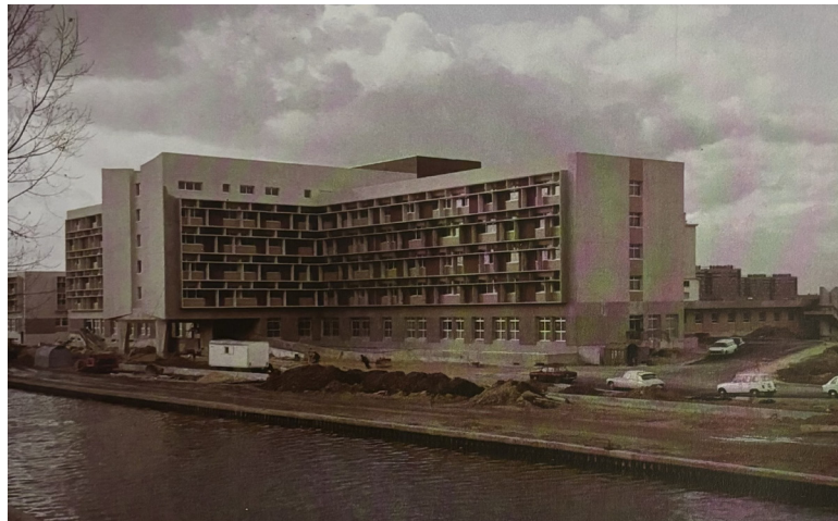
Figure 61 : Photo du bâtiment 100 des archives de l'AP-HP
