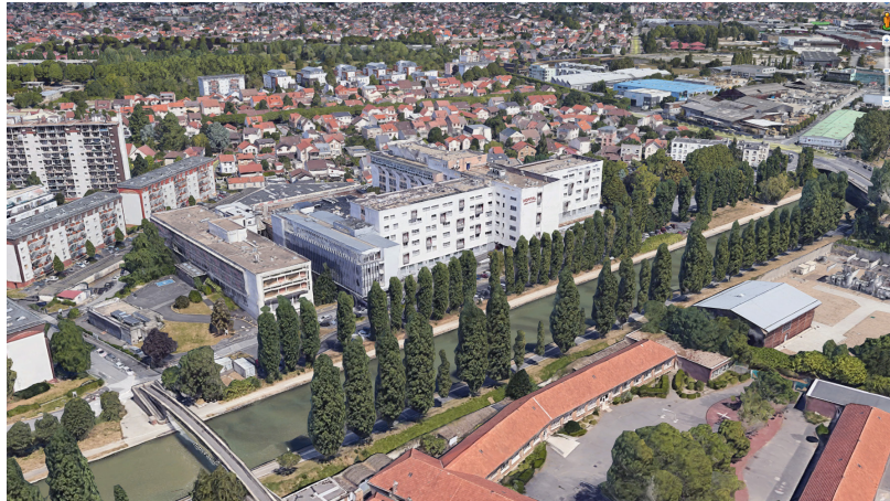
Figure 35: Image aérienne de l'hôpital Jean Verdier issue de Google earth
