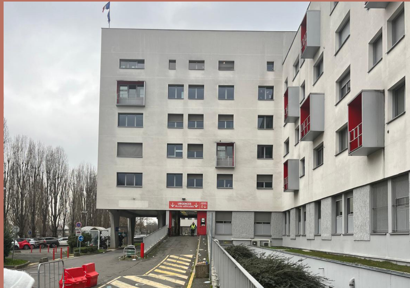
Figure 23: Photo actuelle de l'hôpital Jean Verdier
