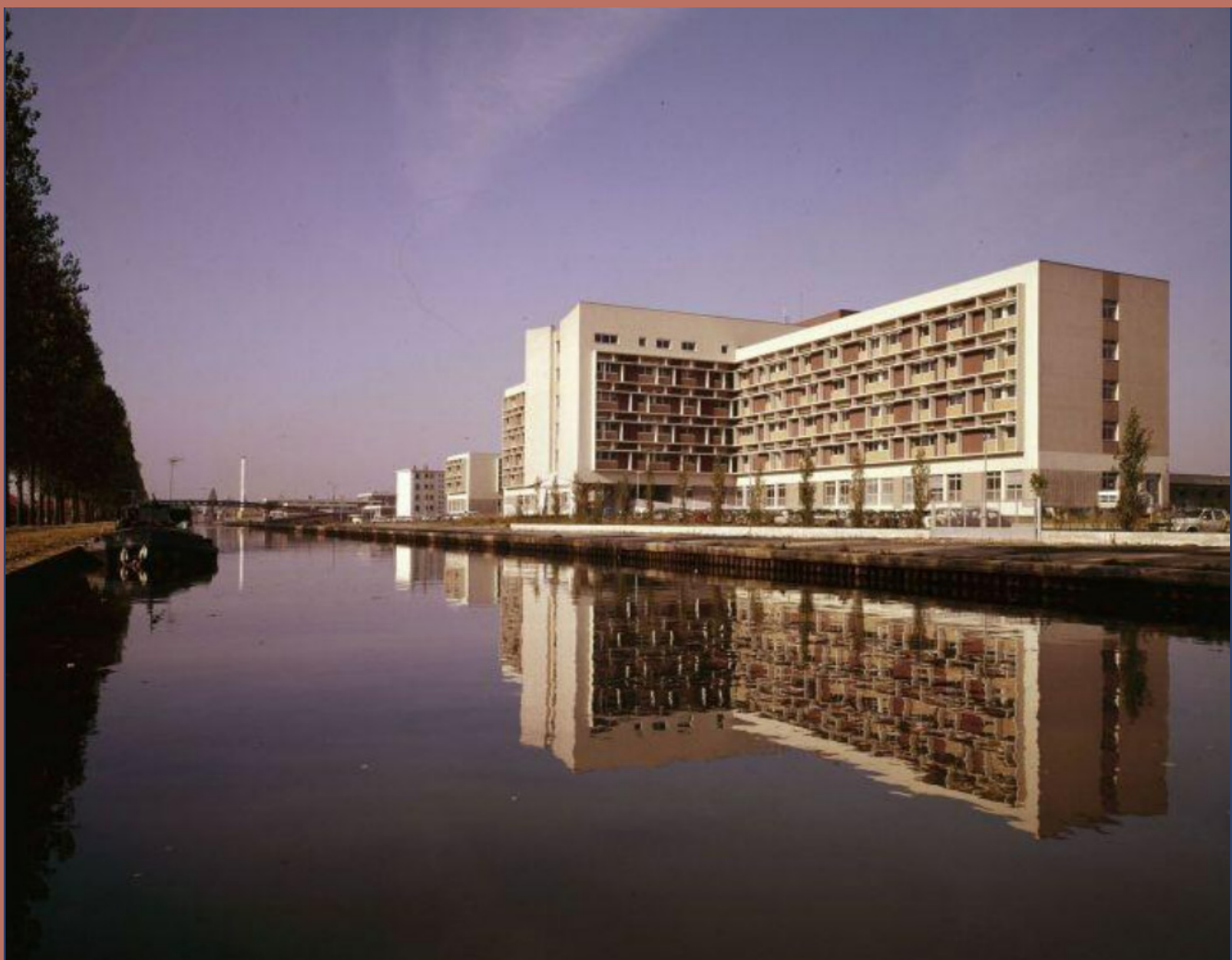
Figure 1: Photo de chantier de l'hôpital Jean Verdier, issue des archives de l'APHP, Bondy 1973
