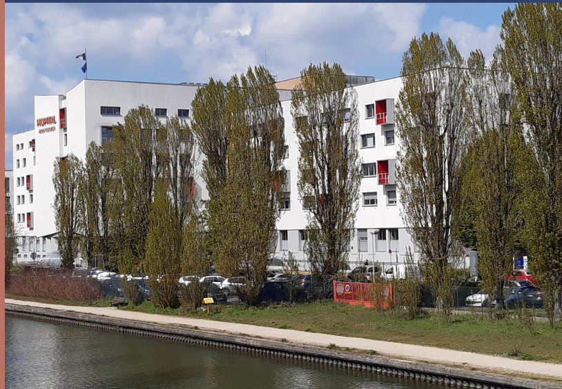
Figure 22: Photo actuelle de l'hôpital Jean Verdier
