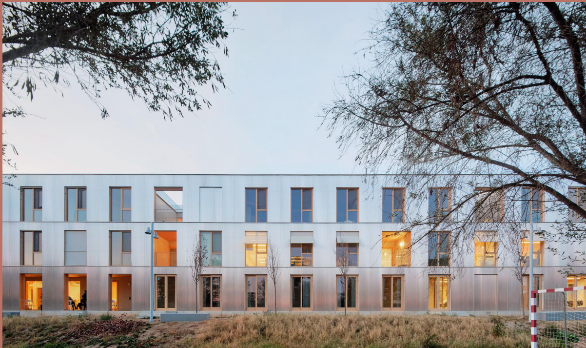
Figure 45 : Facade du centre d'hébergement
