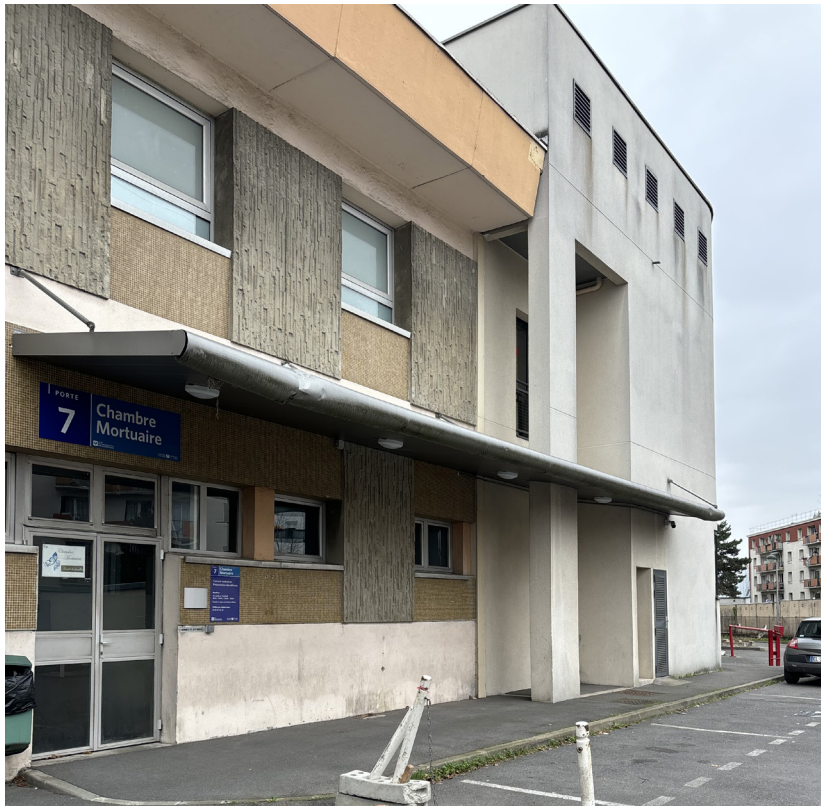
Figure 41: Photo des façades Nord des bâtiments
