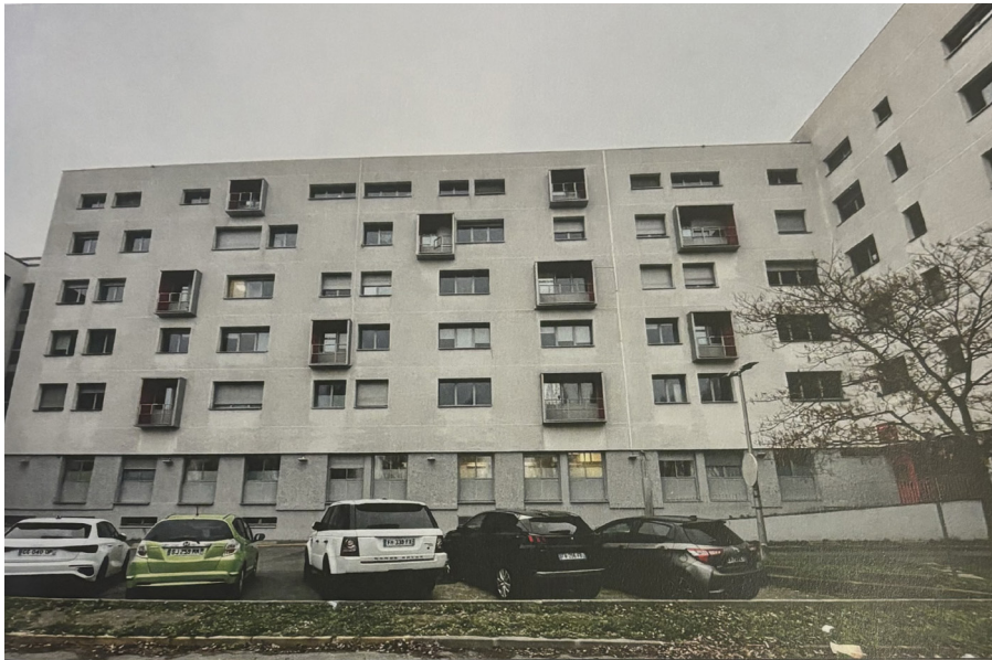
Figure 62 : Photo personnelle du bâtiment 100 actuel
