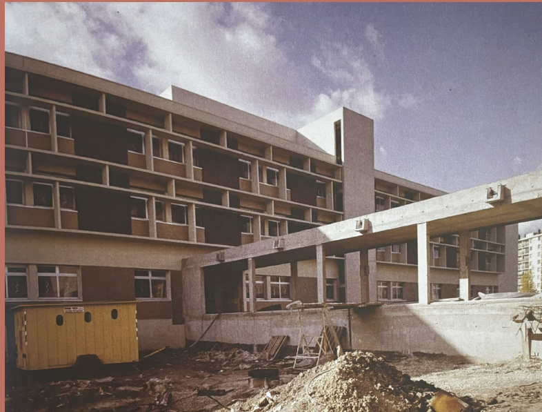
Figure 55 : Photo des archives des façades de la maternité (1973-1975)
